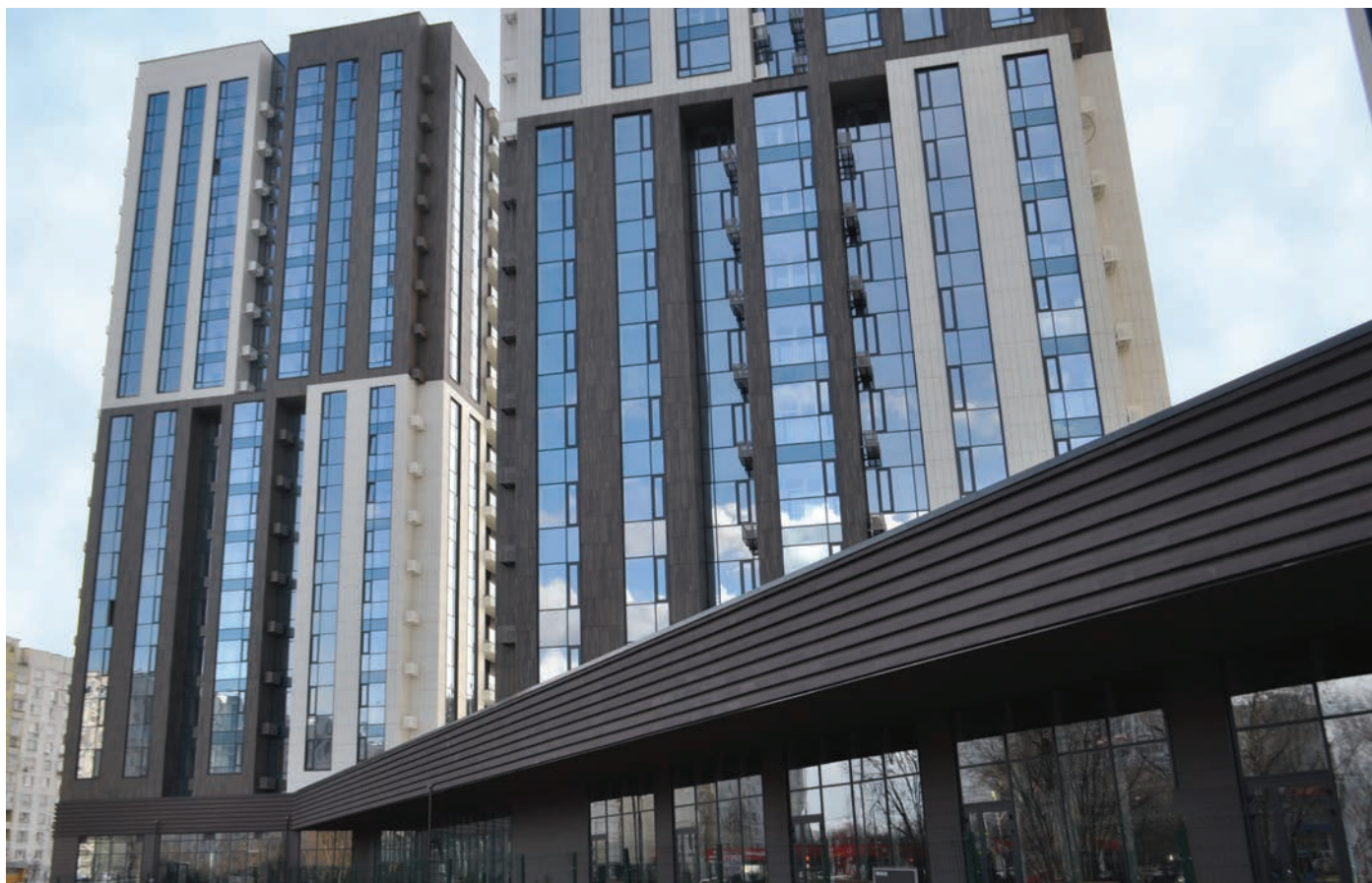
Россия, г. Москва, Ривер Парк Плиты ТС-03 Багеты – ТС-04
